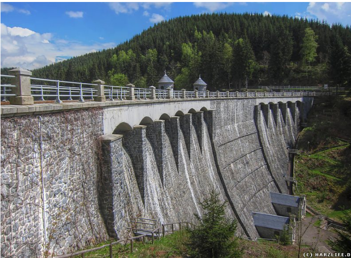
Die Staumauer der Talsperre Neustadt wurde in den Jahren 1904-1905 aus Bruchsteinen errichtet.
